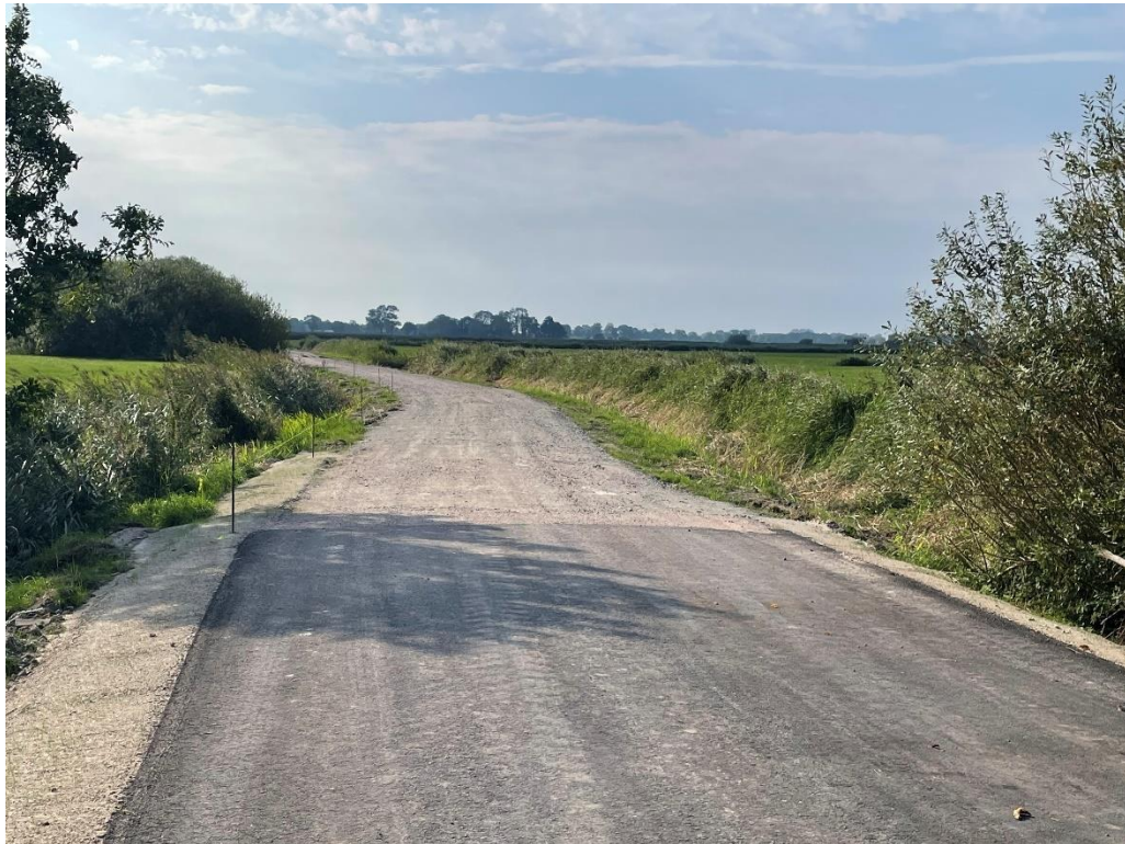
Abbildung 6 Umgehung Oldorf, Anschlussstelle Uthausen mit Blick nach Osten; im Süden verläuft das Neuwarfer Leide
