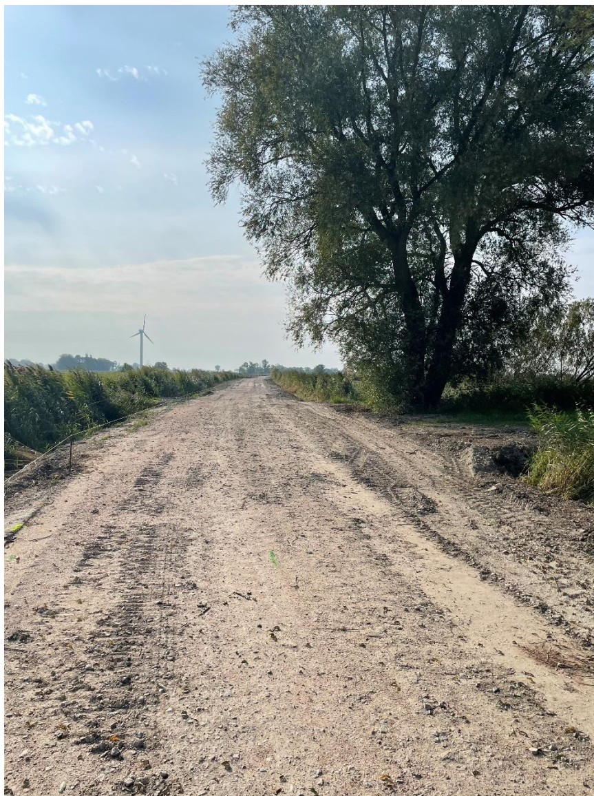
Abbildung 20 Vorhandene Schotterbefestigung der Umgehung Oldorf
