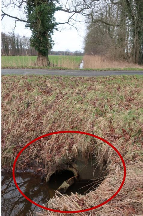
Alle Rohr-und Rahmendurchlässe werden im Zuge des Wegebaus mit erneuert.
